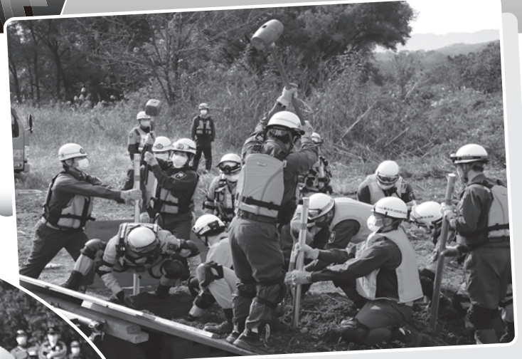
土留(活動する場所を安全にする作業)の様子
